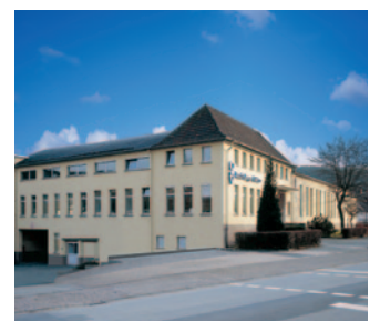
Завод в г. Ауэ располагает производственными площадями более 14 000 м 2
