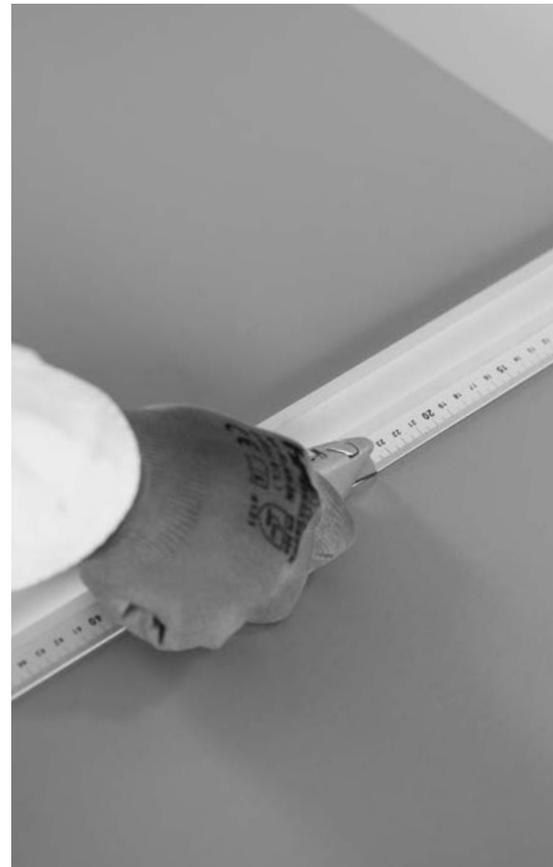
Sichtkontrolle beim Zuschnitt der Linoleumbahnen.
